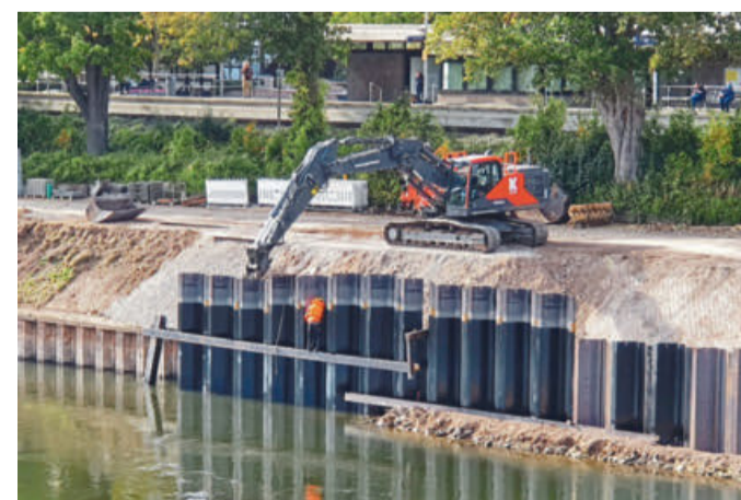
Baustelle Weserufer: Seit Wochen laufen die Arbeiten an der Weserpromenade. In Kürze geht es auf der Brücke los. Foto: M. Robrecht
